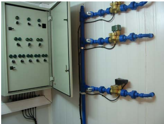
Interior Sala de Comandos Equipo HF100S (Tablero de Control y Sistema Hidraulico)
